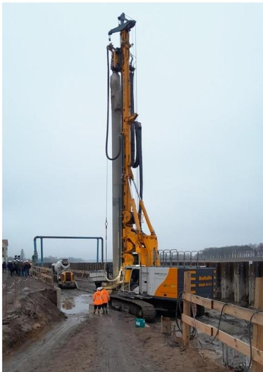
Abbildung 18 – Herstellung Bohrpfähle
