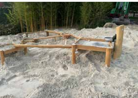
Als GAK-Kleinprojekt wurde eine neue Matschanlage im Freibad Ennigerloh gebaut, die dort vor allem den kleinen Besuchern viel Freude an warmen Tagen im nassen Sand bereitet.
